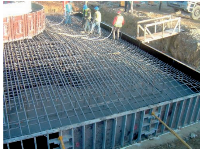
Arbeiten am Erdungssystem einer Windenergieanlage
