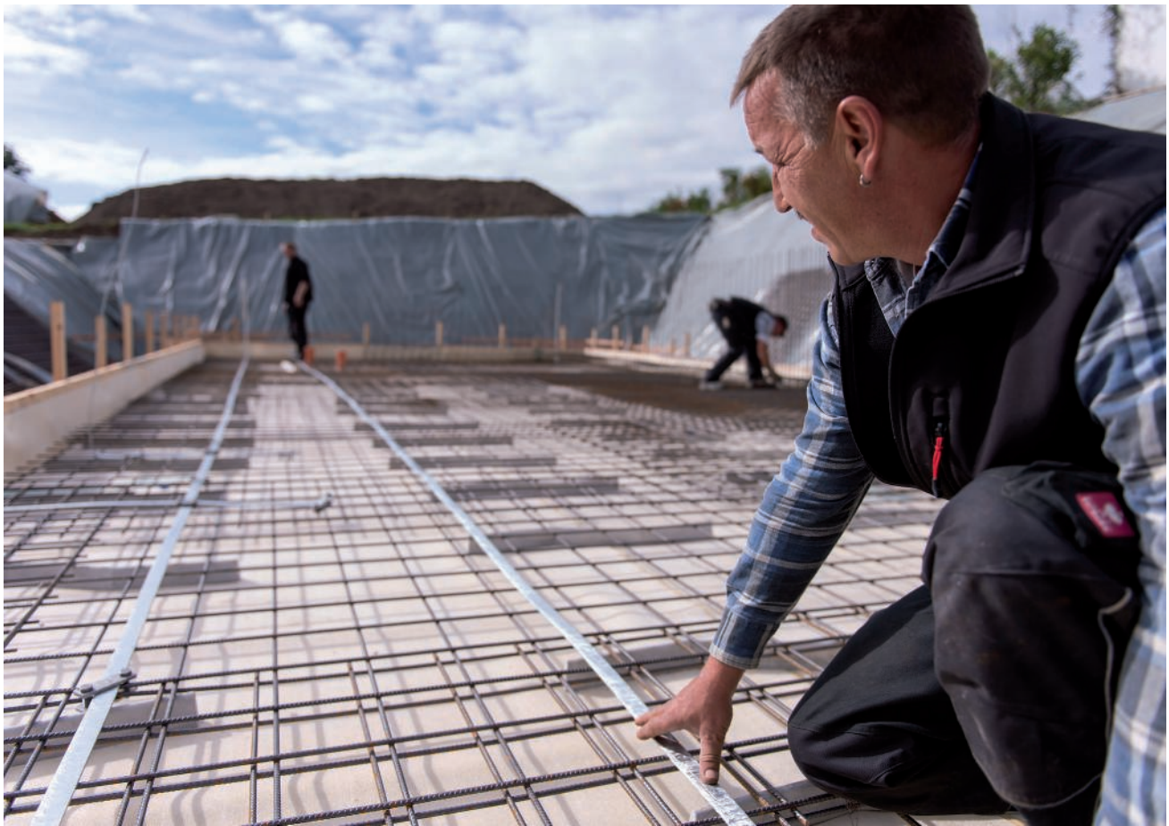
Verlegung eines Fundamenterders
