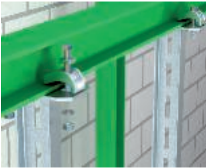
Serrage direct sur poutre acier Crapautage direct sur poutre métallique d'un pendent en I avec crapaud de serrage (lourd) de type TKS-S-30. Cheminement parallèle à la poutre en acier.
