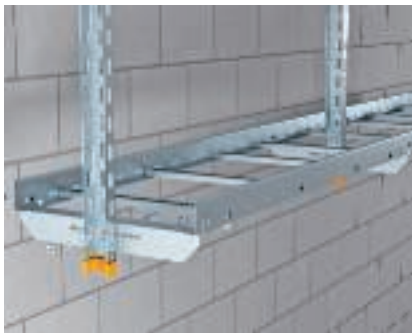
Suspension centrale d'échelle à câbles avec profilé en U Montage d'une échelle à câbles avec suspension centrale MAHU et un profilé en U.
