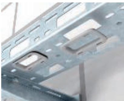
Bague de protection de câble, fond Pose des bagues de protection de câble KSR-915 au fond du canal support de luminaires.
