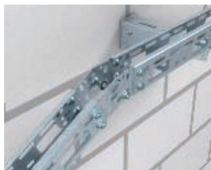
Eclissage vertical Eclissage vertical du rail de support luminaires de type LTS avec deux éclisses droites et d'angle de type VF AZK.
