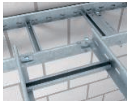
Montage d'un té de dérivation Réalisation d'un départ en T horizontal pour deux échelles à câbles de hauteurs différentes. L'équerre de support LAW est nécessaire pour fixer les échelles à câbles les unes avec les autres.
