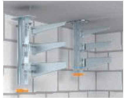
Montage de console Montage d'un système de support de câbles à 3 niveaux sur un plafond en béton à l'aide des consoles à griffes AS 15, AS 30 et AS 55.
