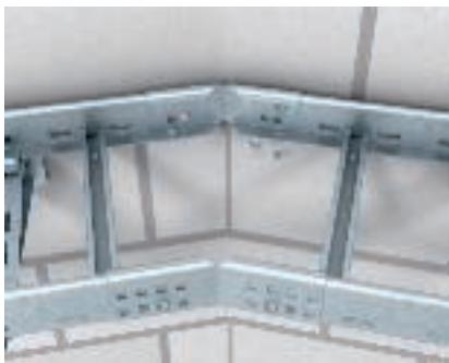
Éclissage d'angle horizontal d'échelles à câbles Éclissage d'angle horizontal avec éclisses droites et d'angle de type LWVG.
