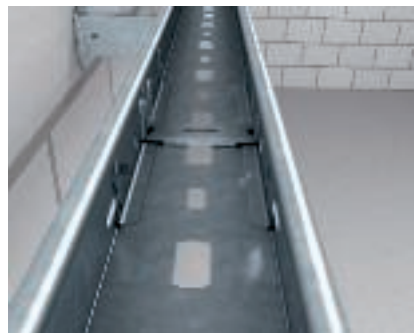
Éclissage de canal support de luminaires Éclissage horizontal du canal support de luminaires LTR avec kit d'éclissage droit de type RV 607.
