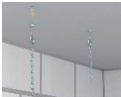
Suspension par chaînette Réalisation d'une suspension par chaînette pour canal support de luminaires avec chevilles, crochets de plafond 948/TG6 et chaînette de suspension LTK-K.
