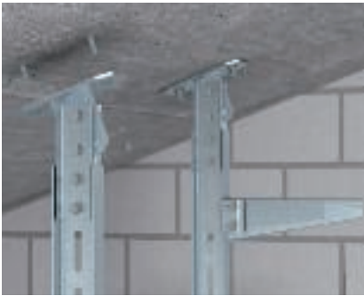
Plaque de tête orientable Montage de la plaque de tête orientable KI 8 VQP sur un plafond incliné en béton, à l'aide de chevilles d'ancrage de type FAZ II.
