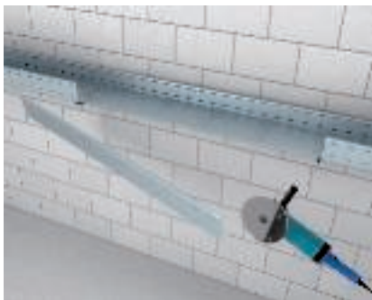
Réalisation d'un té de dérivation avec pièce d'angle à monter Séparation de l'aile sur le chemin de câbles longue portée continu.
