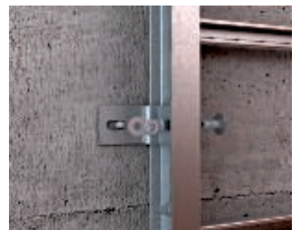
Fixation d'échelle verticale industrielle Fixation murale d'une échelle verticale industrielle avec équerre de fixation de type BW 80/55.
