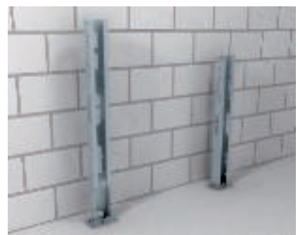
Montage d'une colonne d'alimentation moteur avec pied de colonne Fixation de la colonne d'alimentation moteur MAS 140/10 au sol avec un pied de colonne de type SF 140/11.
