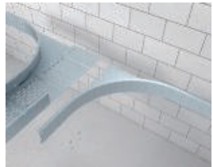
Réalisation d'un té de dérivation avec pièce d'angle à monter Montage de la deuxième pièce d'angle à monter WEAS 110.
