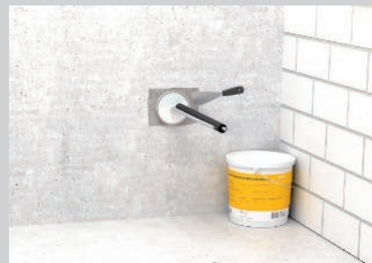
Anpassung Schaumstoffstopfen an Installationen mit einem Messer und rauchgasdichte Versiegelung der Oberflächen mit Beschichtungsmasse ASX.
