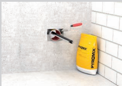
Verschließen der Öffnung mit Mörtel PYROMIX®.
