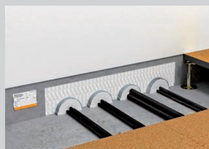
Fertig installierte Halbschale im Weichschott PYROPLATE® Fibre.
