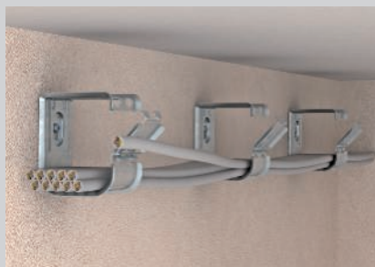
Einfaches Einlegen der Kabel in die geöffnete Sammelhalterung.
