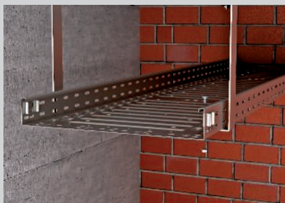
Befestigung der Kabelrinne mit Flachrundschräuben.
