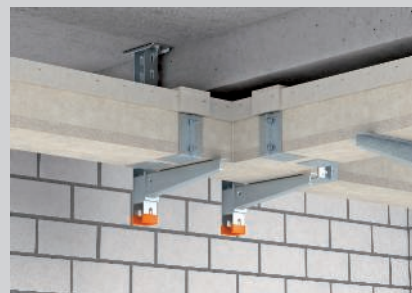
Vormontierte Standardformteile im Trassenverlauf.
