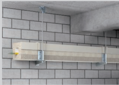
Wandmontage auf Auslgern und zusätzlicher Gewindestangesicherung.
