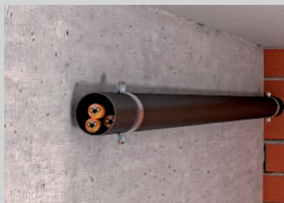
Mehrfachbelegung laut Angaben der Prüfzeugnisse.
