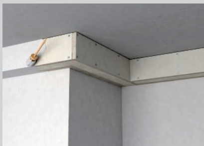
Abschließende Oberflächenbehandlung durch Streichen oder Tappezieren.
