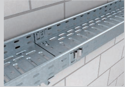
Fertige schraubenlose Stoßstellenverbindung.
