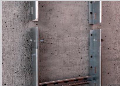
Stoßstellenverbindung mit verschraubtem Verbinder.
