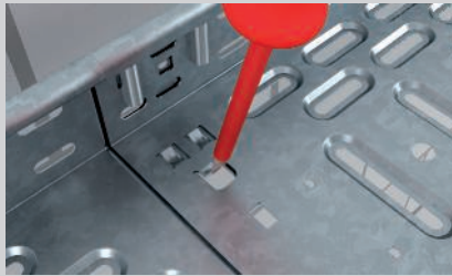
Umbiegen der Sicherungslaschen im Boden.
