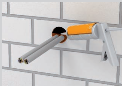
Verschließen der Öffnung mit der Spachtelmasse FBA-SP.
