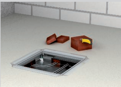
Schmale Streifen für die Kanalzüge zuschneiden.
