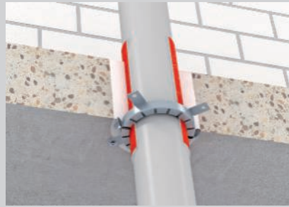
Montage an der Deckenunterseite mit Metalldübeln.
