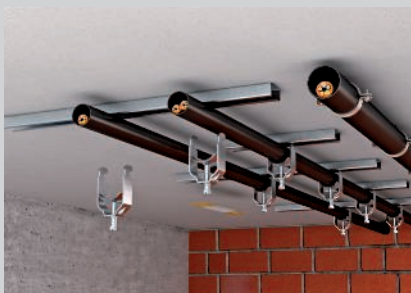
Deckenmontage mit Schraubabstandschelle und Bügelschelle.
