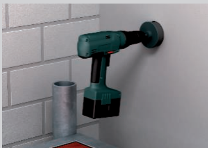
Bohren eines Lochs mit einem Dosenbohrer.
