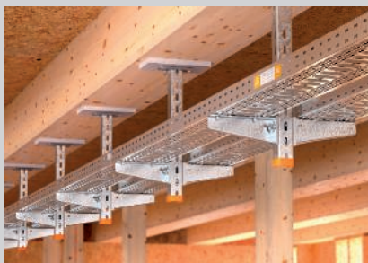
Hängestielmontage unter dem Holzbalken mit hinterlegter Brandschutzplatte.
