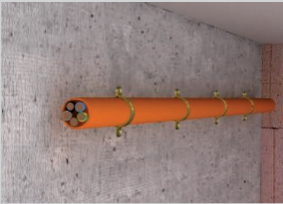
Waagerechte Montage der Kabel an der Wand.
