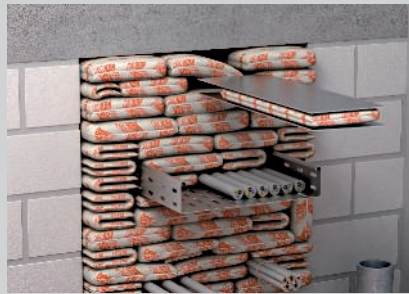
Bleche als Montagehilfe für die letzte Kissenschottlage.
