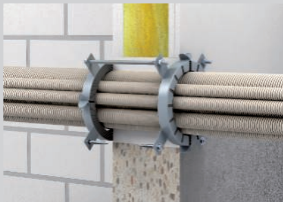
Beidseitige Anordnung der Rohrmanschetten bei Wandmontage.
