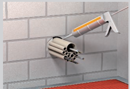
Verschließen der Ringspalte mit Dämmschichtbildner DSX.
