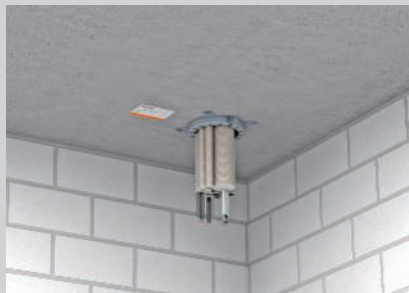
Montage an der Deckenunterseite mit Metalldübeln.
